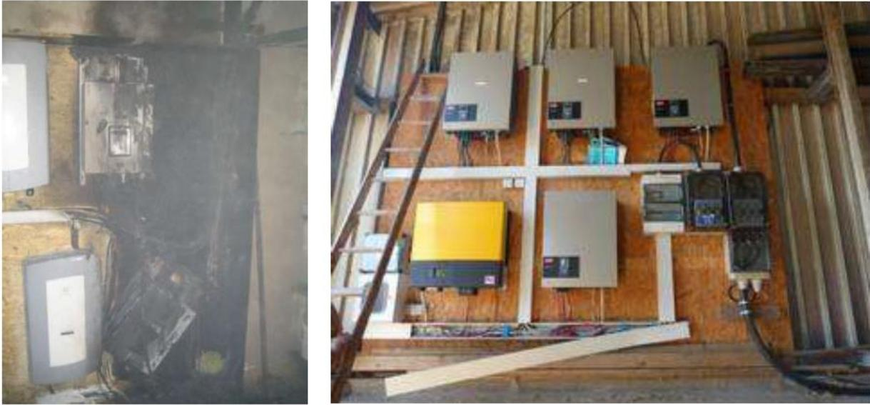
**Figura 3-32: Montaje del inversor en tableros de madera OSB; a la izquierda, aquí fue lo ocurrido. Foto: Voluntarios del cuerpo de bomberos del municipio de Perl, 2011. A la derecha: aquí luce bien a la vista, pero no está acorde con la normativa de protección contra incendios. Foto W. Schröder, experto en FV, 2014.**
