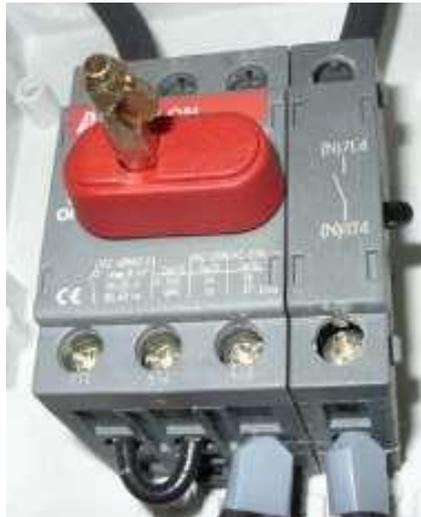
**Figura 3-26: interruptor principal CC tipo palanca probado.**
