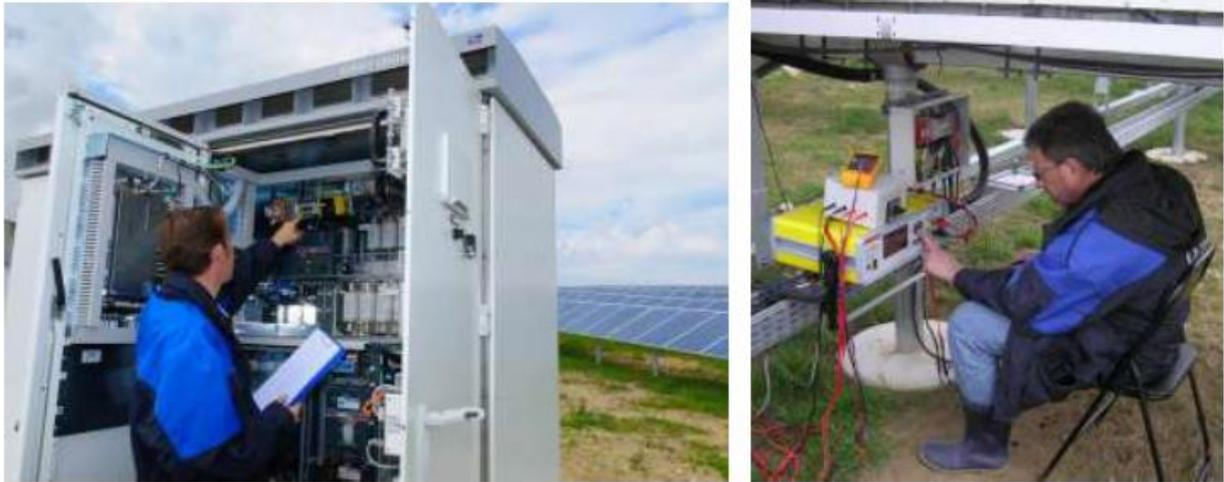
**Figura 5-34: Control visual (izquierda en el WR) y medición (derecha en el GAK) durante la recepción**
