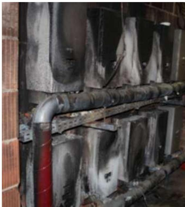
**Figura 3-23: Recinto técnico de una planta FV después de un incendio.**
