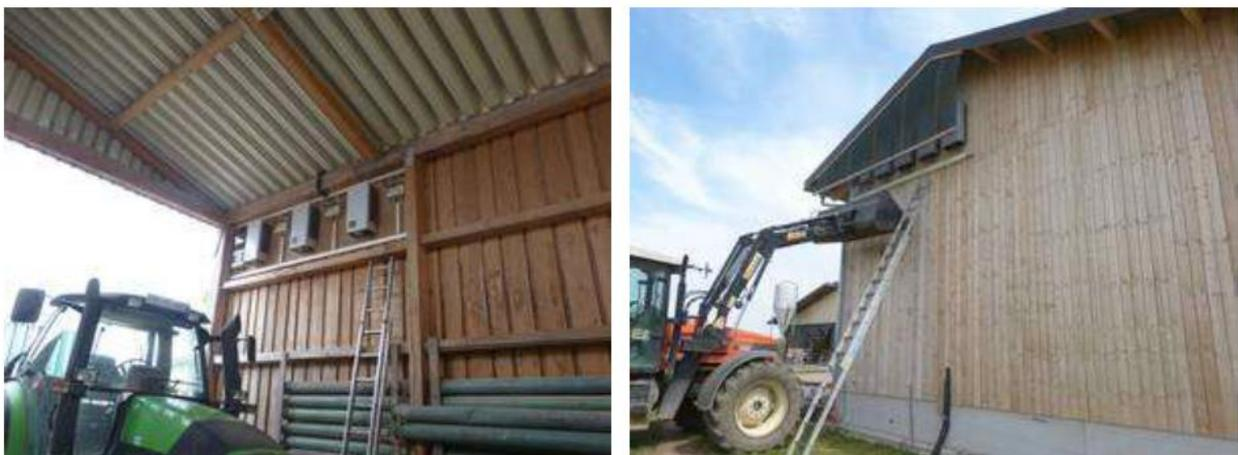
**Figura 3-14: La instalación incorrecta de inversores sobre madera no cumple con la seguridad contra incendios, además, es difícil de alcanzar para el mantenimiento. Fotos: W. Schröder, experto FV, 2014.**
