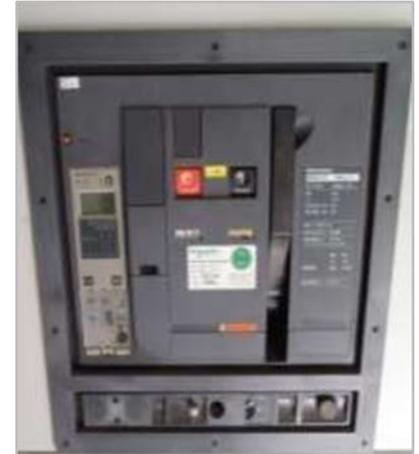
**Figura 5-40: Interruptor seccionador**
