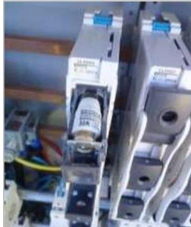
**Figura 5-39: Separador con fusible**
