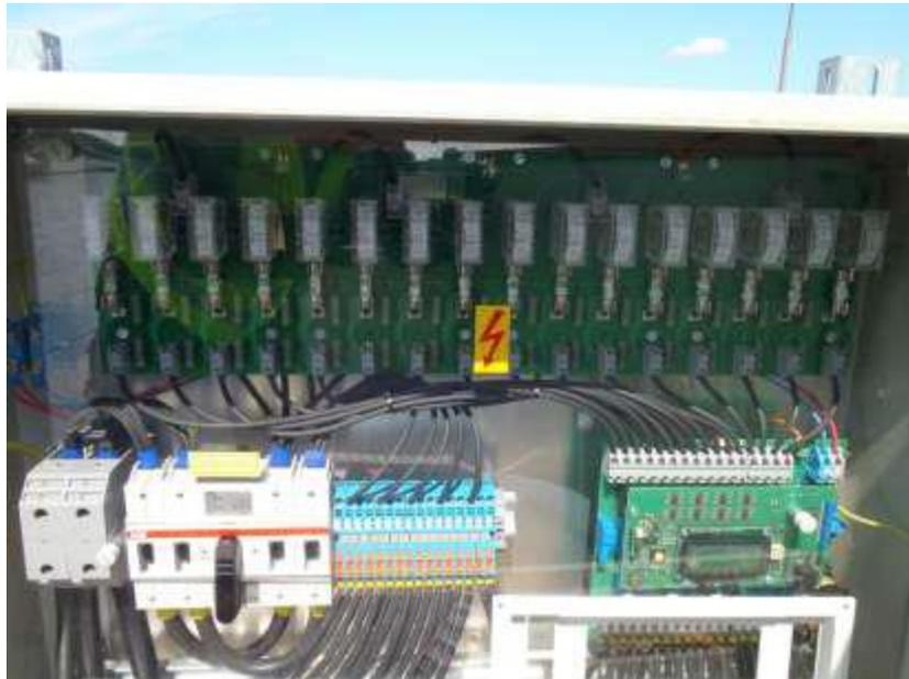
**Figura 5-37: Caja de toma de corriente de generador con interruptor bajo carga y bornes de separación**
