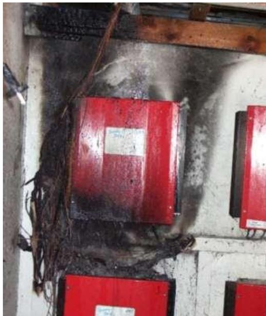
**Figura 3-31: Conductores quemados de un inversor (Fuente: Cuerpo de bomberos de Weyerbusch)**
