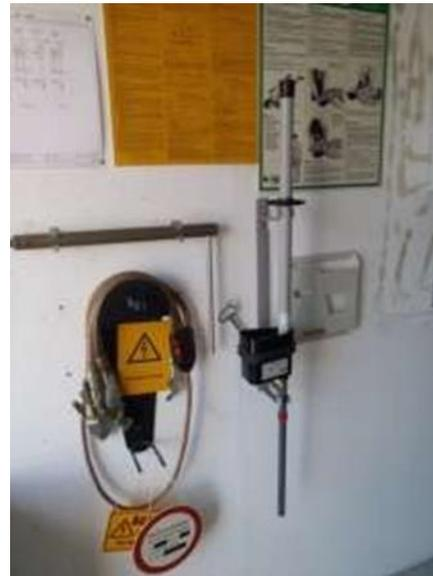
**Figura 5-42: Kit de contacto a tierra y cortocircuito para el transformador**
