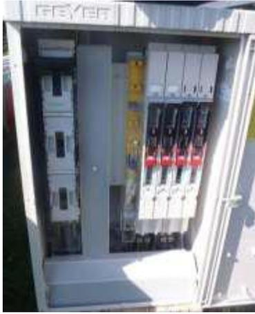
**Figura 5-38: Porta-fusible con función de separar**
