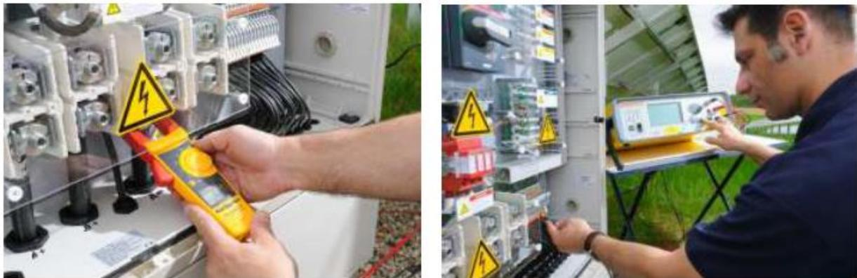
**Figura 5-33: Mediciones en las cadenas del generador, en la caja de bornes**
