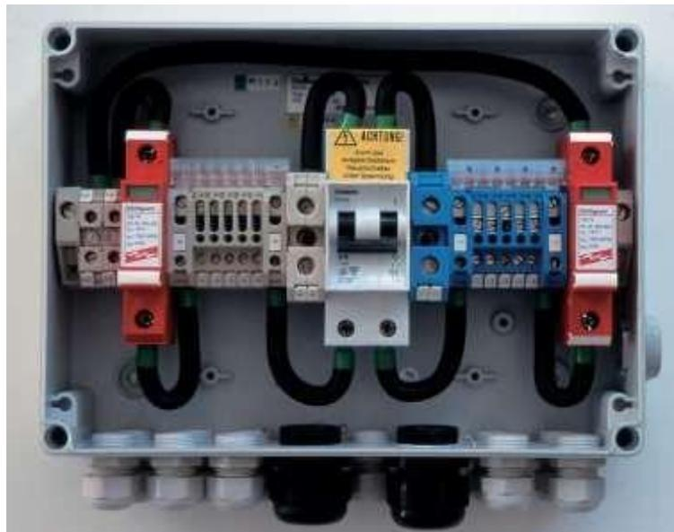
**Figura 3-51: Caja de conexiones del generador [Fuente: DGS-Berlín]**
