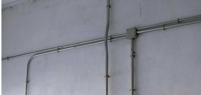
Ilustración 15. Ejemplo de instalación bajo tubo.
