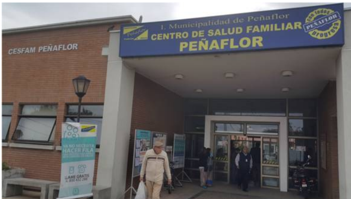
Ilustración - Fachada edificio seleccionado
