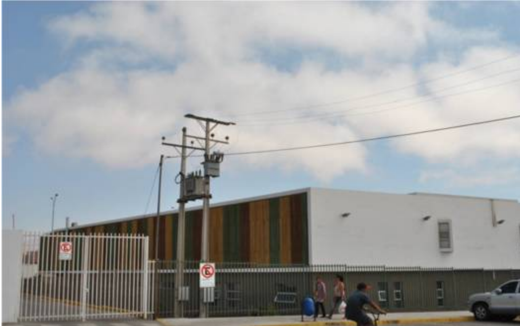
Ilustración - Fachada edificio seleccionado
