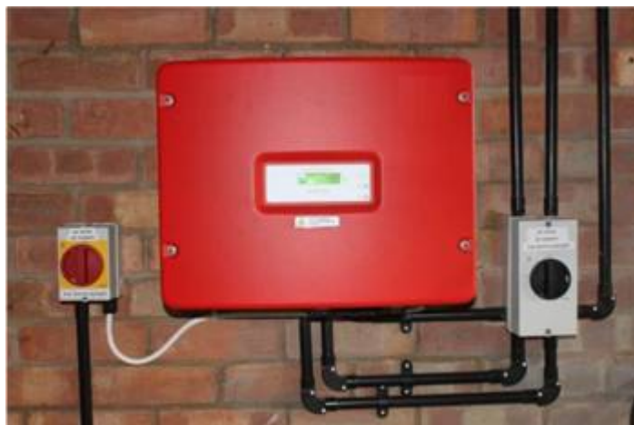
Ilustración -Típico montaje de un inversor
