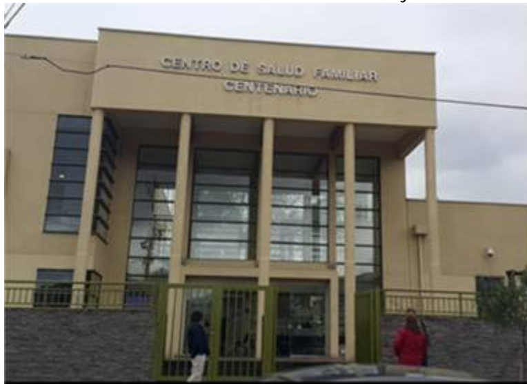
Ilustración - Fachada edificio principal
