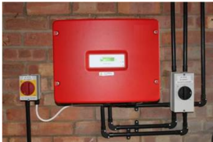
Ilustración -Típico montaje de un inversor
