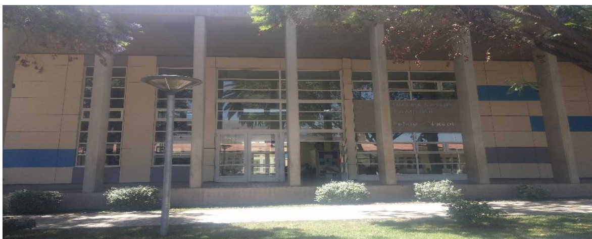
Ilustración - Fachada edificio seleccionado
