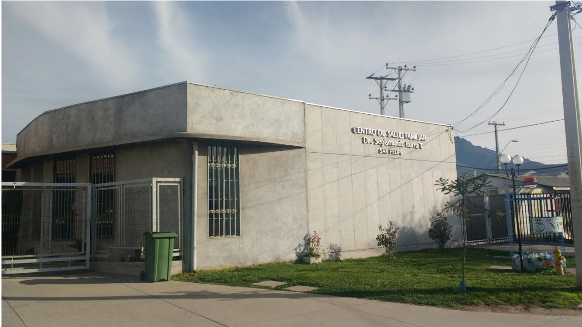
Ilustración - Fachada edificio seleccionado
