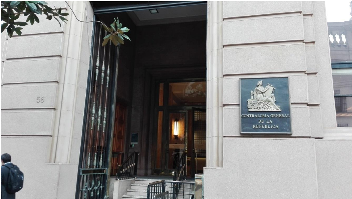
Ilustración - Fachada edificio seleccionado
