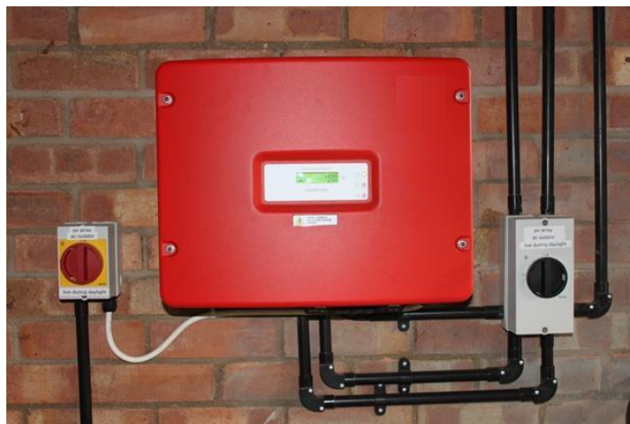
Ilustración -Típico montaje de un inversor
