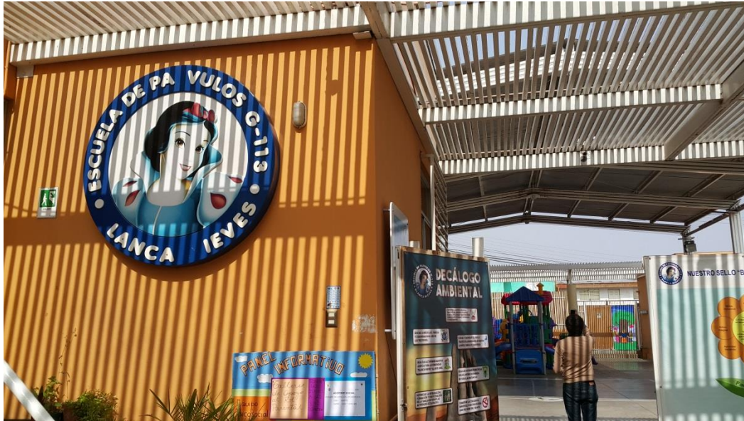
Ilustración - Fachada edificio seleccionado
