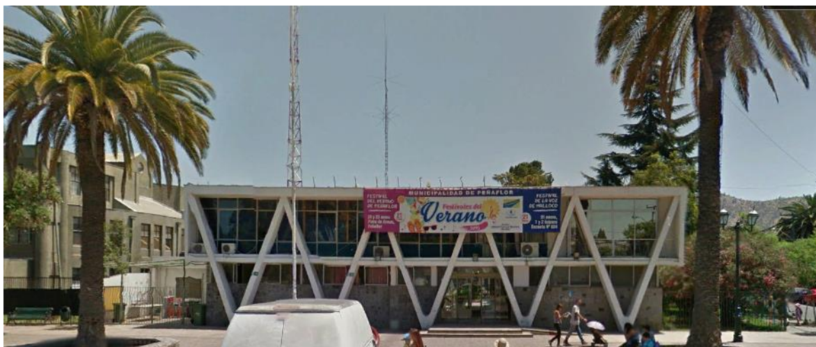
Ilustración - Fachada edificio seleccionado
