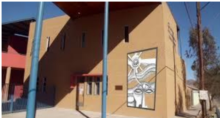
Ilustración - Fachada edificio seleccionado
