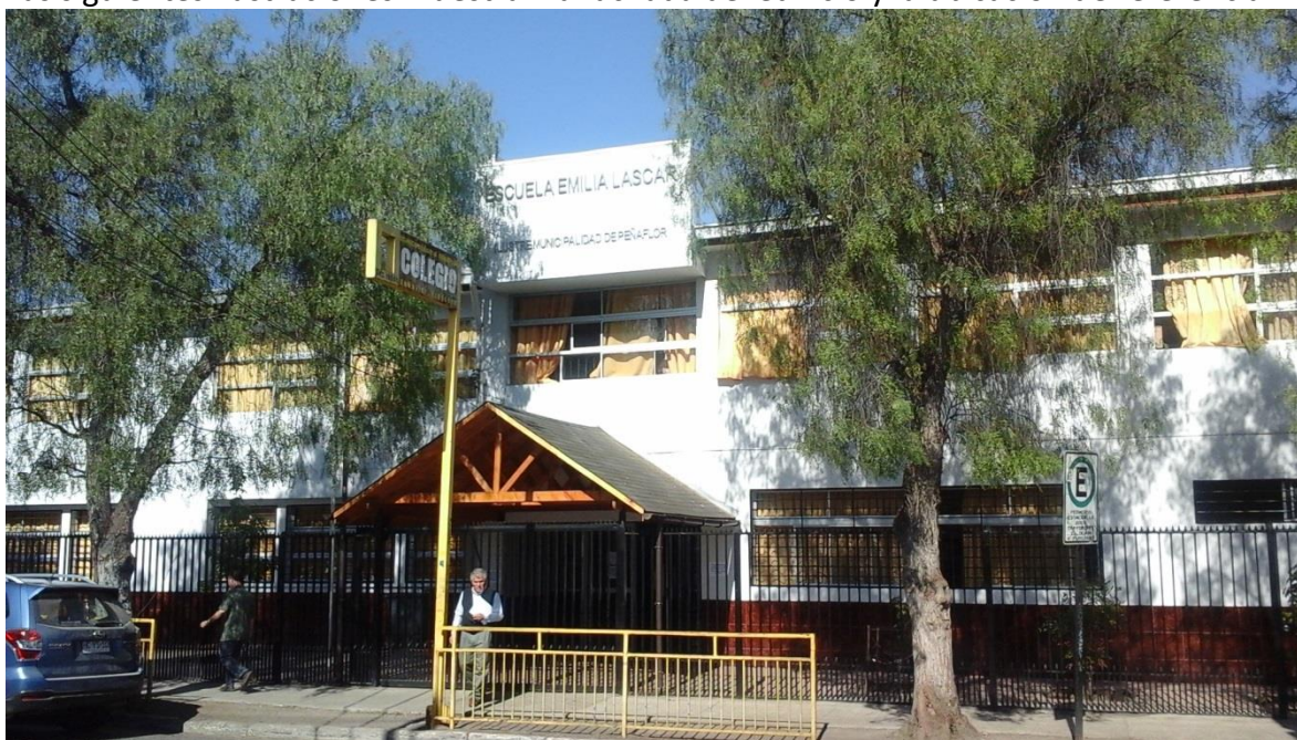
Ilustración - Fachada edificio seleccionado
