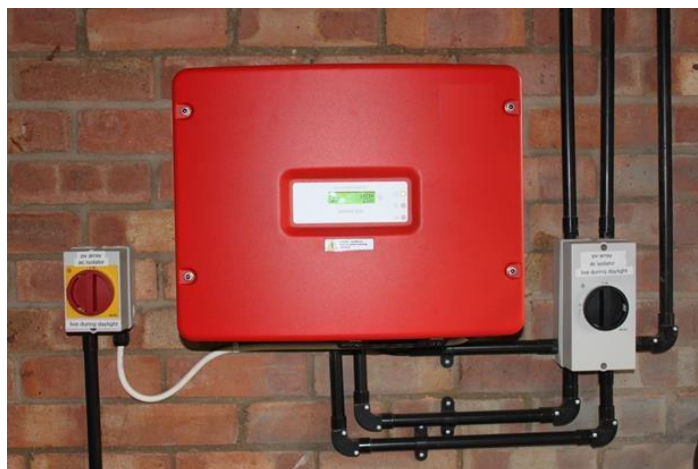
Ilustración -Típico montaje de un inversor
