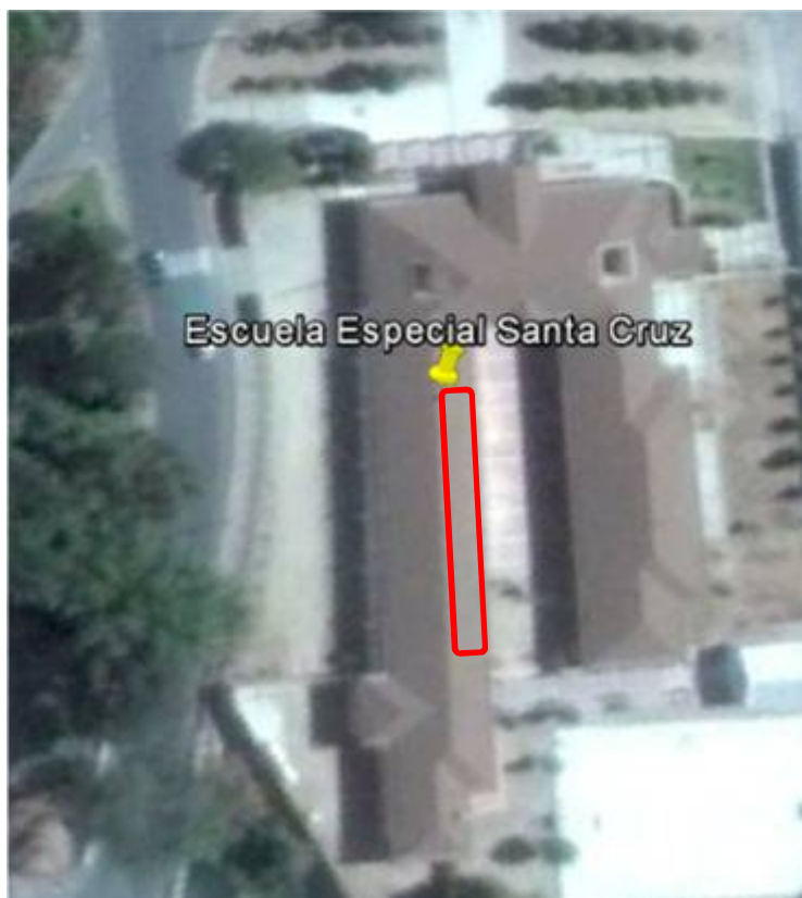
Ilustración - Ubicación del edificio por Google Earth
