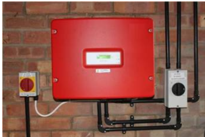
Ilustración -Típico montaje de un inversor
