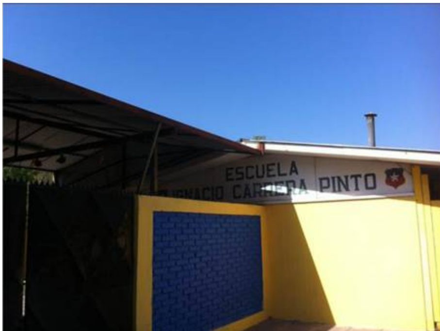
Ilustración - Fachada edificio principal
