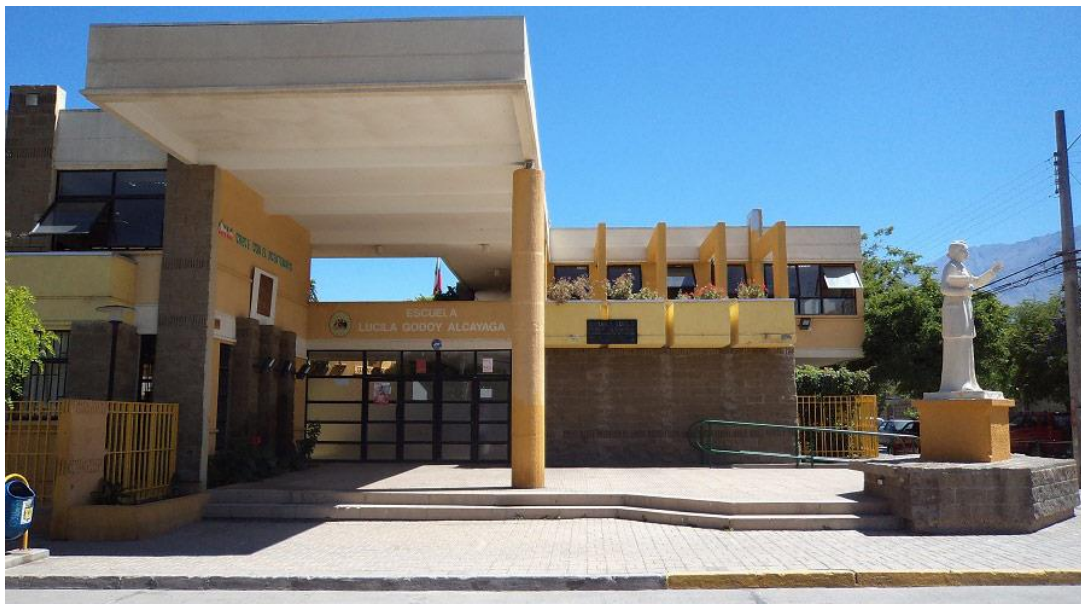
Ilustración - Fachada edificio seleccionado
