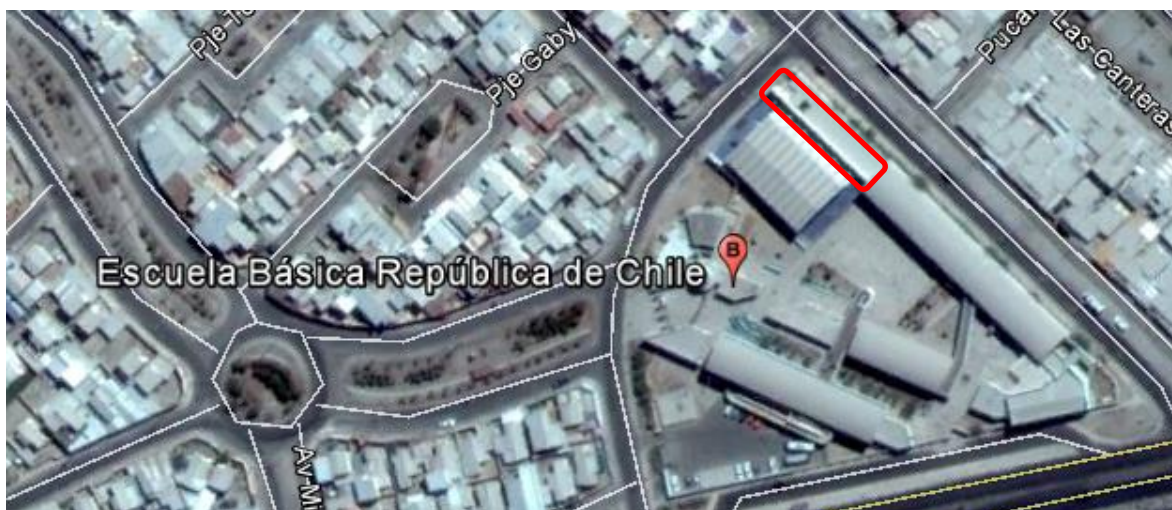
Ilustración - Ubicación del edificio por Google Earth
