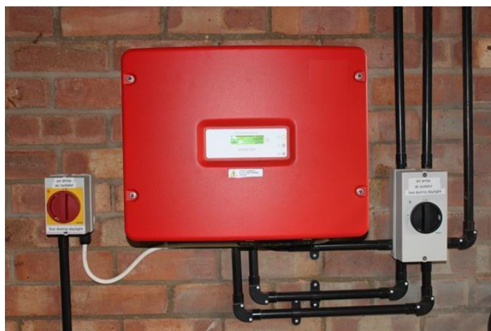
Ilustración -Típico montaje de un inversor
