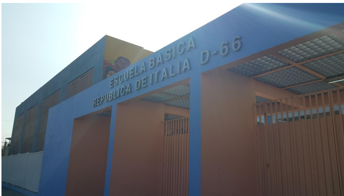
Ilustración - Fachada edificio seleccionado
