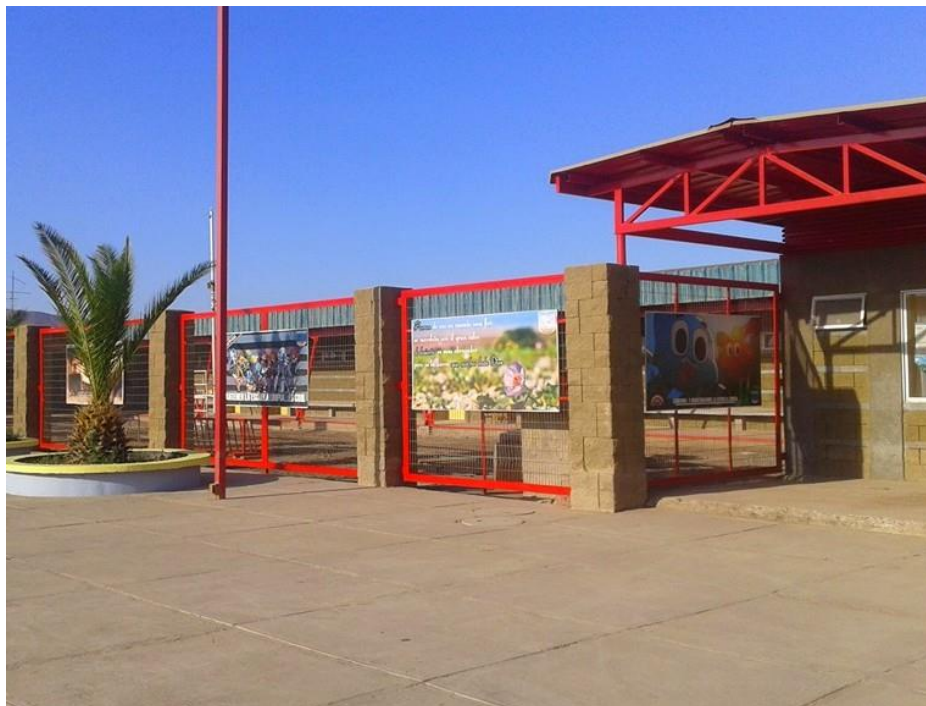
Ilustración - Fachada edificio seleccionado
