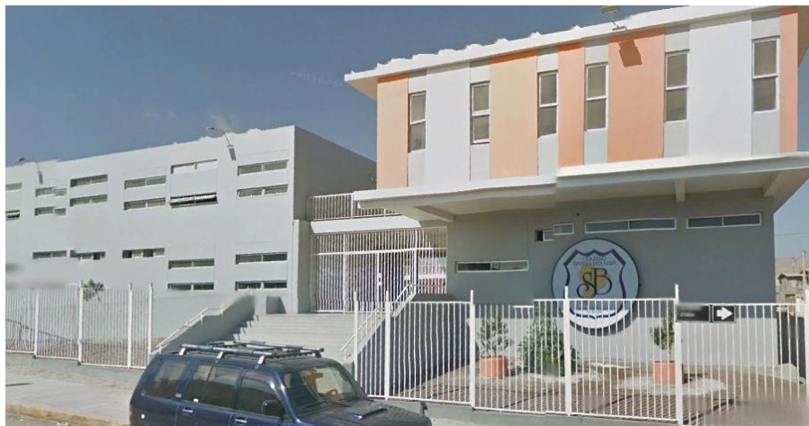
Ilustración - Fachada edificio seleccionado
