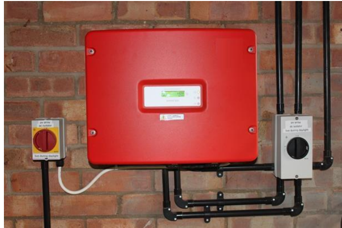
Ilustración -Típico montaje de un inversor
