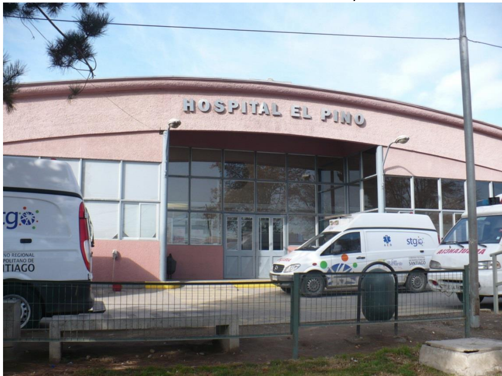
Ilustración - Fachada edificio seleccionado
