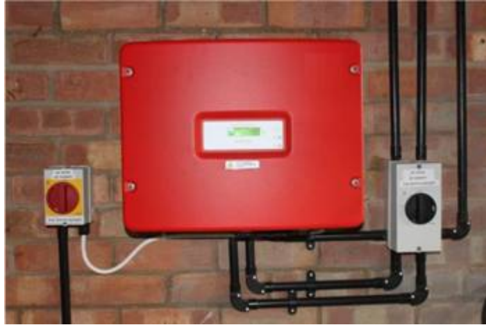
Ilustración -Típico montaje de un inversor
