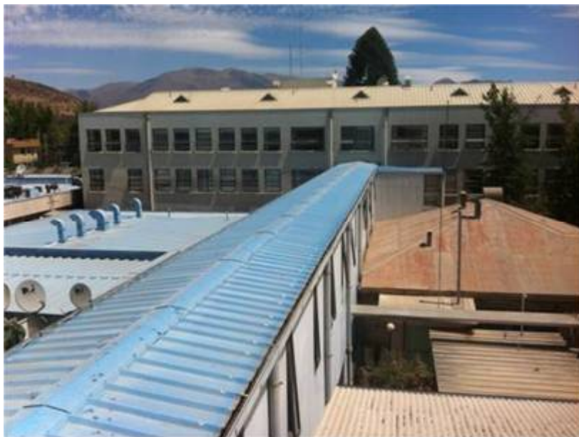
Ilustración - Fachada edificio seleccionado
