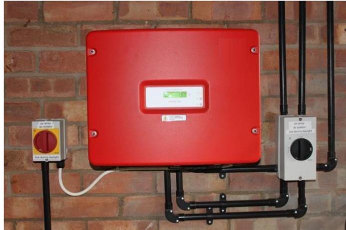
Ilustración -Típico montaje de un inversor
