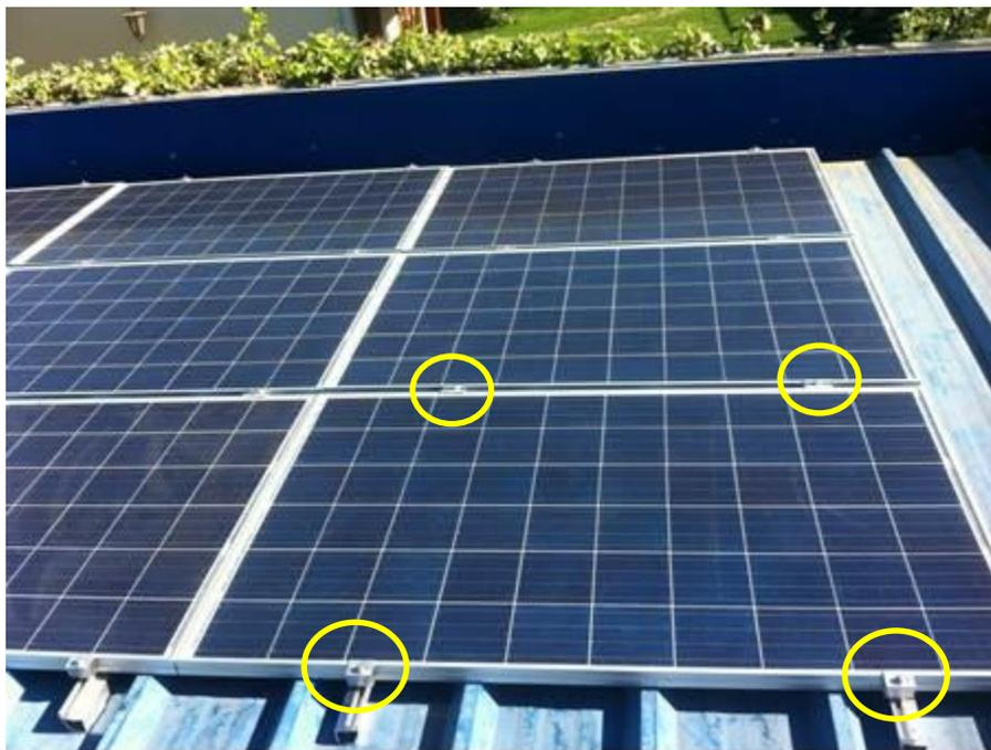
Fotografía proyecto Juzgado de Garantía Parral. En amarillo las grapas finales e intermedias solidarias a la estructura de soporte, la que a su vez se fija a las costaneras de la techumbre del edificio.
