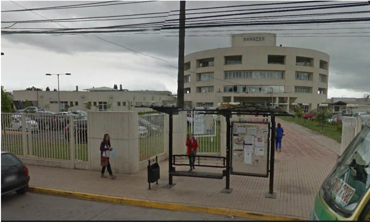
Ilustración - Fachada edificio seleccionado
