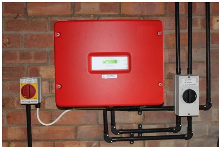
Ilustración -Típico montaje de un inversor
