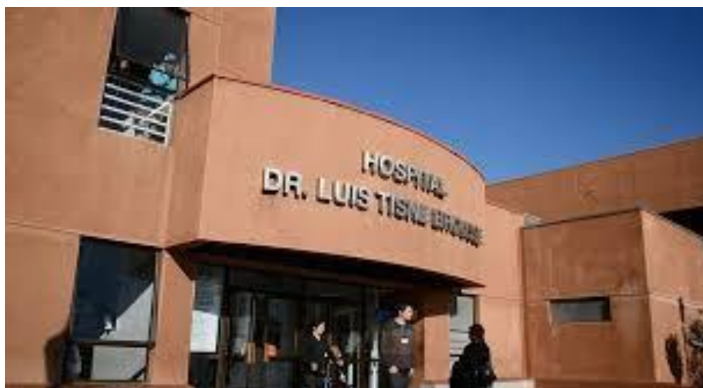
Ilustración - Fachada edificio seleccionado
