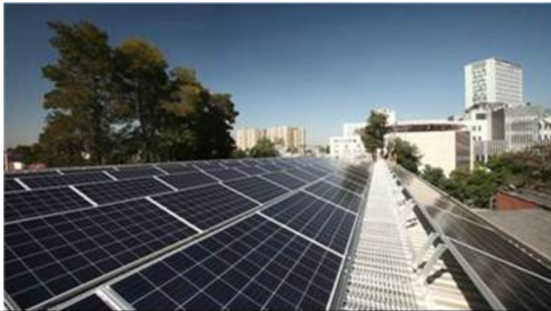
Ilustración - Módulo fotovoltaico tipo, potencia de 250 W, dimensión de 1,6 m x 1 m. Peso aproximado 15 kg. Foto proyecto Teletón Santiago, Programa Techos Solares Públicos.
