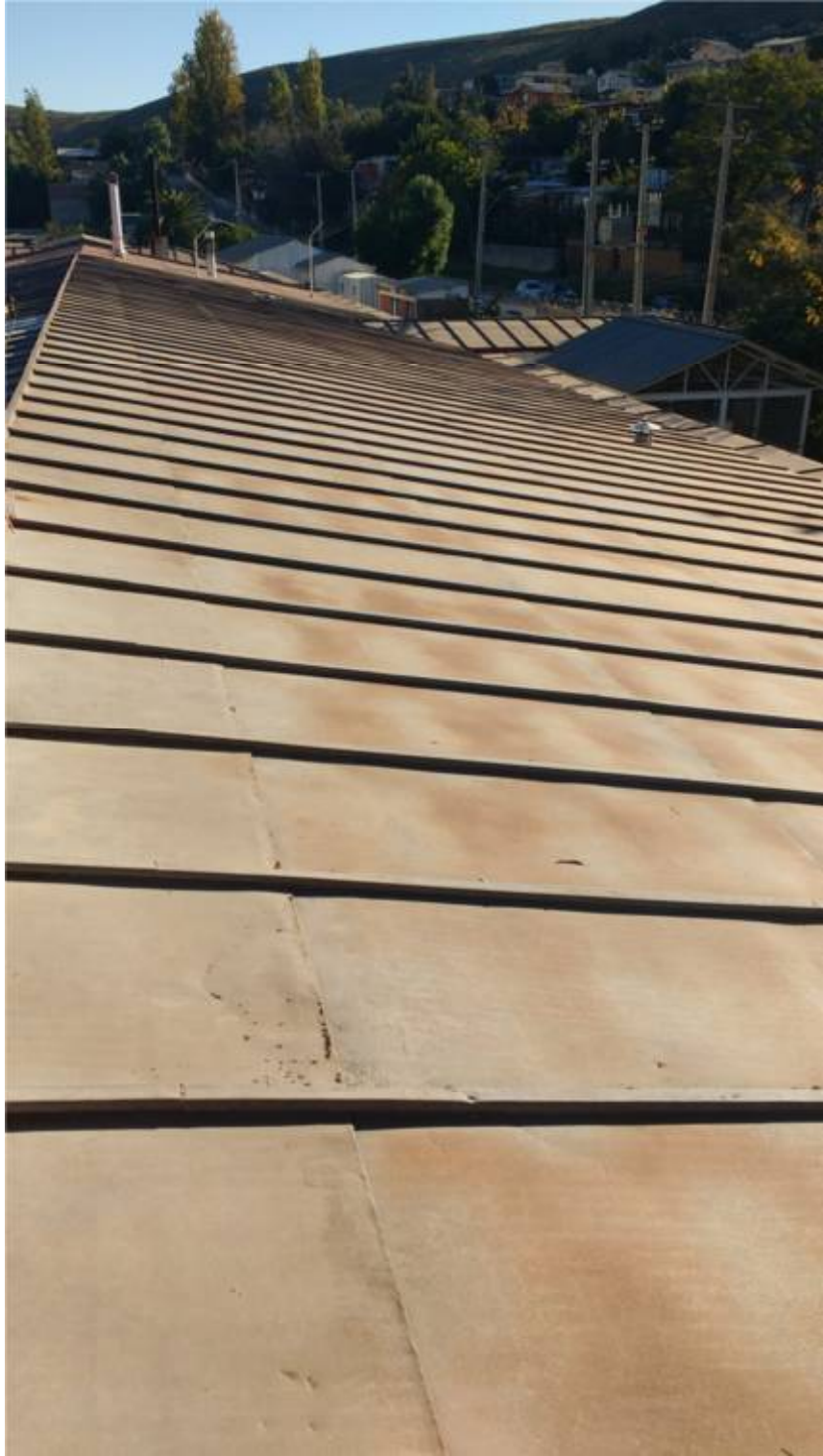
Ilustración – Techo Seleccionado
