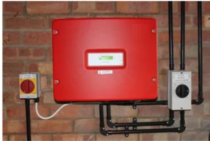
Ilustración -Típico montaje de un inversor
