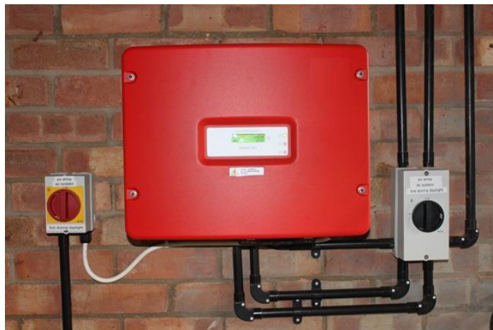
Ilustración -Típico montaje de un inversor
