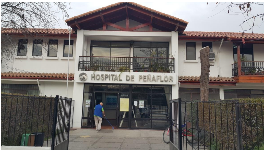
Ilustración - Fachada edificio seleccionado
