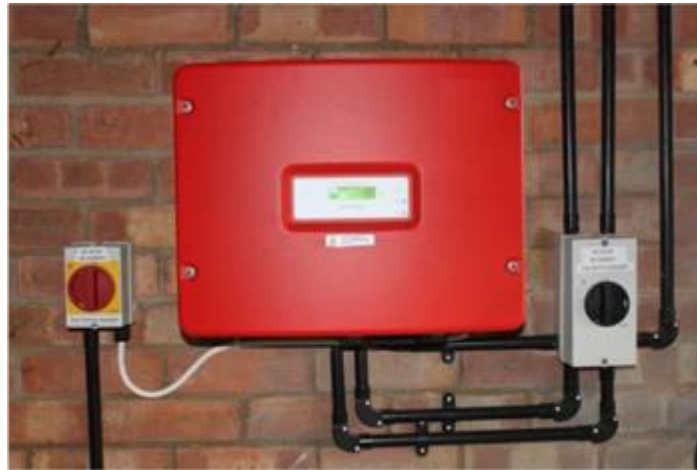
Ilustración -Típico montaje de un inversor
