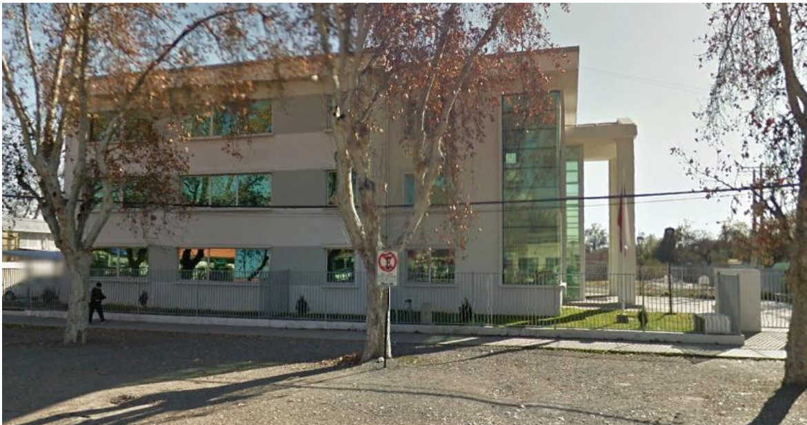
Ilustración - Fachada edificio seleccionado
