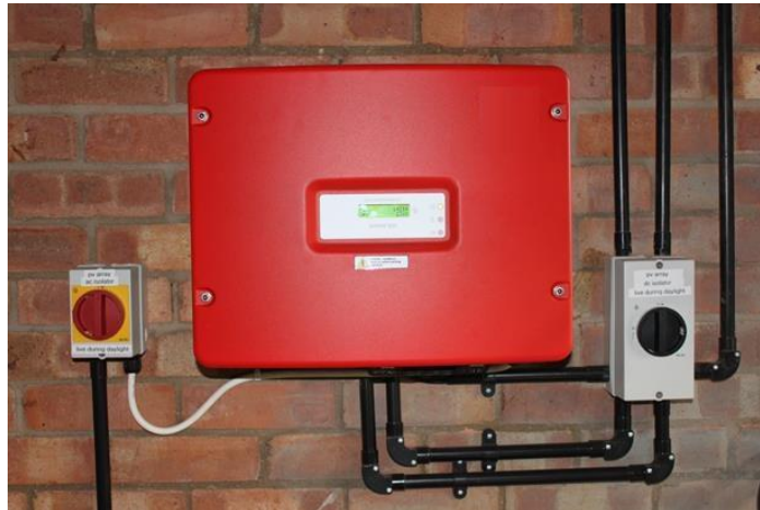
Ilustración -Típico montaje de un inversor
