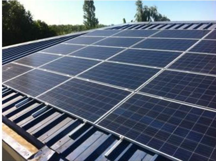
Ilustración – Estructura de anclaje Típica para módulos fotovoltaicos paralela a cubierta. Foto proyecto Juzgado Garantía de Parral, Programa Techos Solares Públicos
