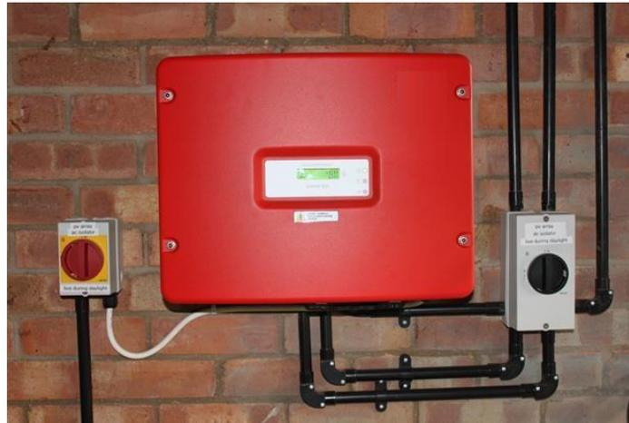
Ilustración -Típico montaje de un inversor
