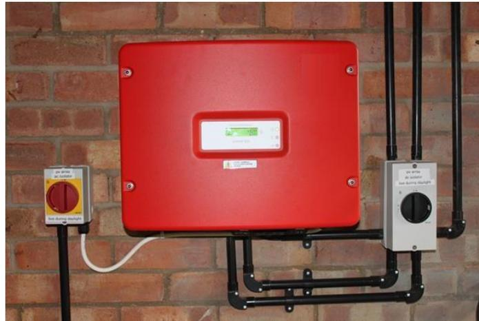
Ilustración -Típico montaje de un inversor
