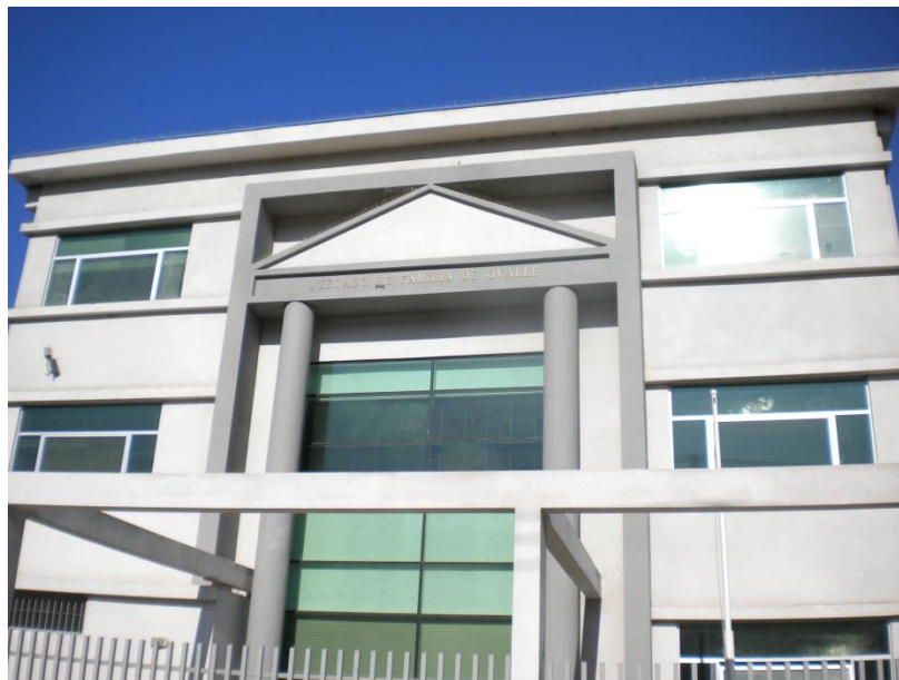
Ilustración - Fachada edificio seleccionado
