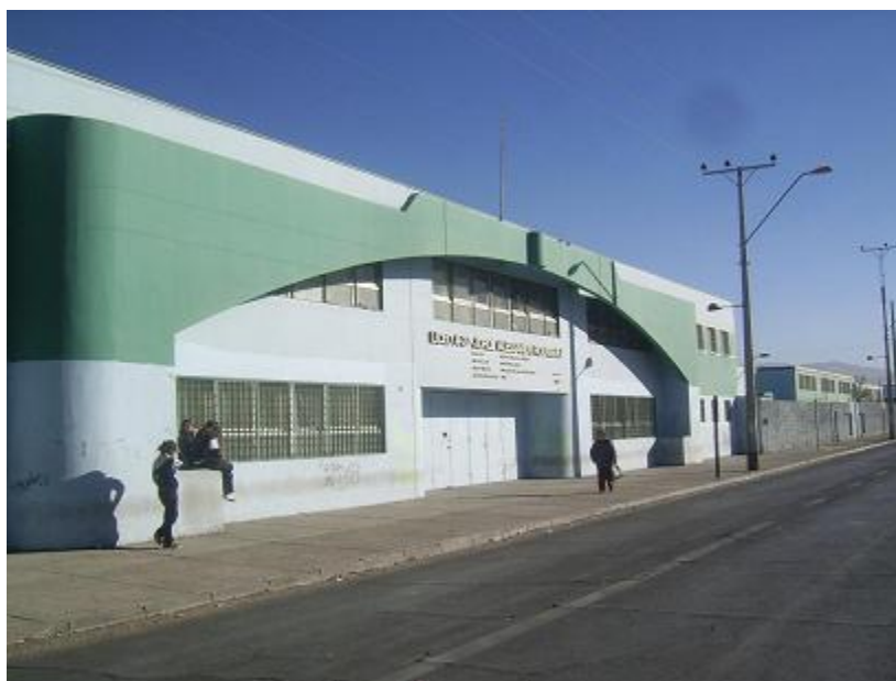
Ilustración - Fachada edificio seleccionado
