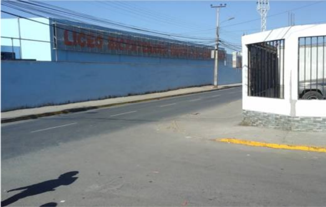
Ilustración - Fachada edificio seleccionado
