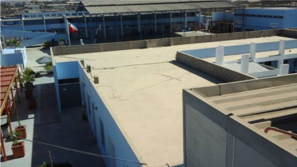
Ilustración – Techo seleccionado vista sur
