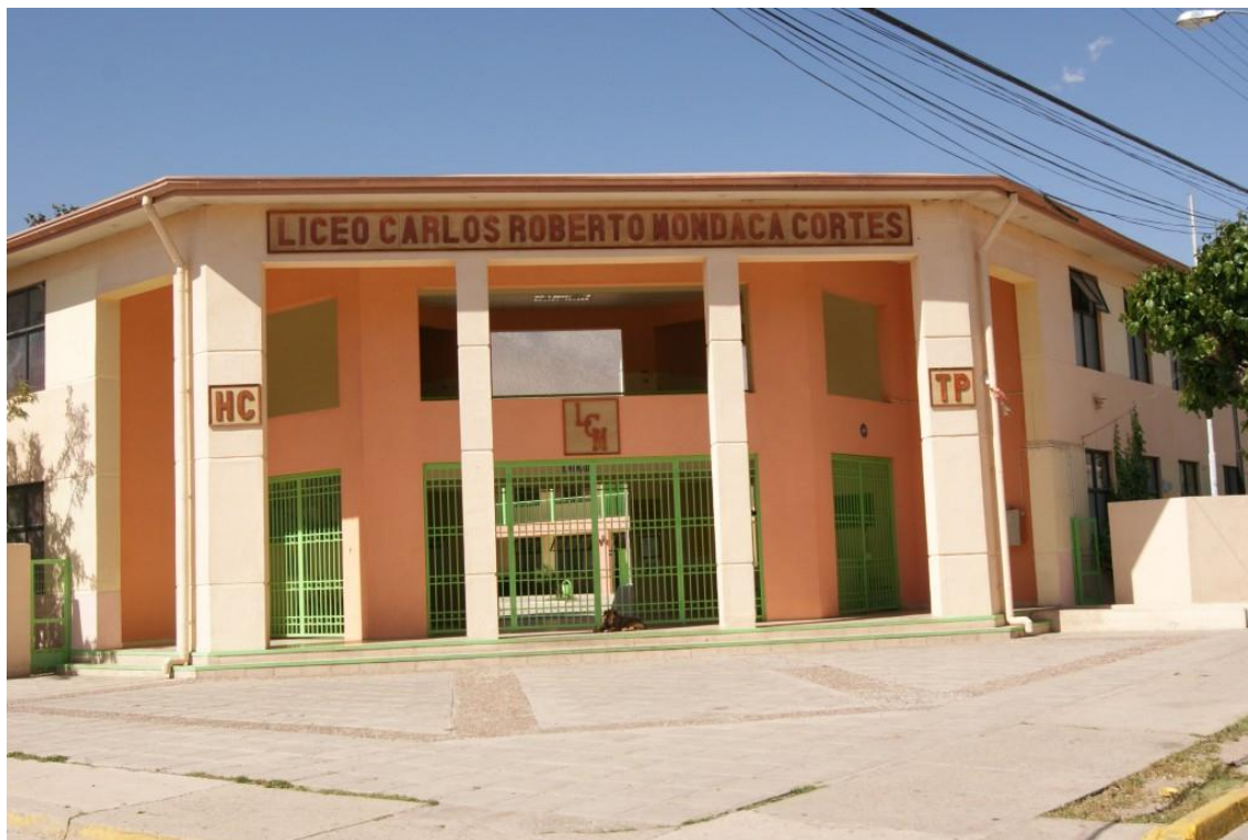
Ilustración - Fachada edificio seleccionado
