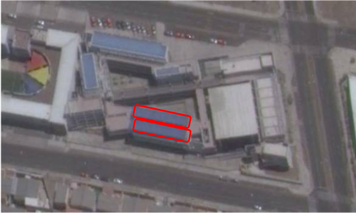
Ilustración - Ubicación del edificio por Google Earth
