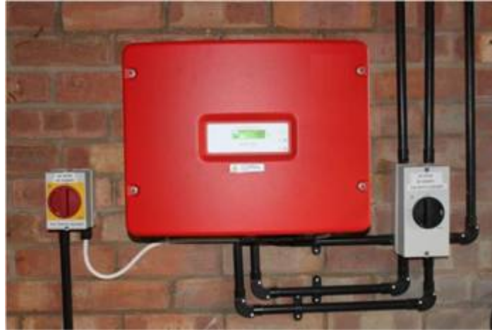
Ilustración -Típico montaje de un inversor
