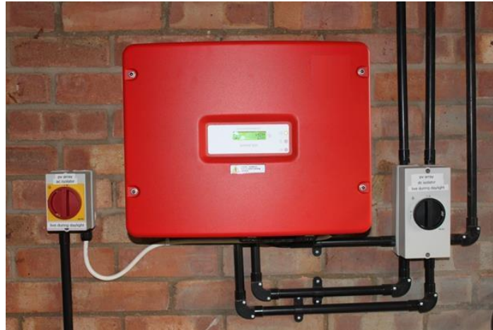
Ilustración -Típico montaje de un inversor
