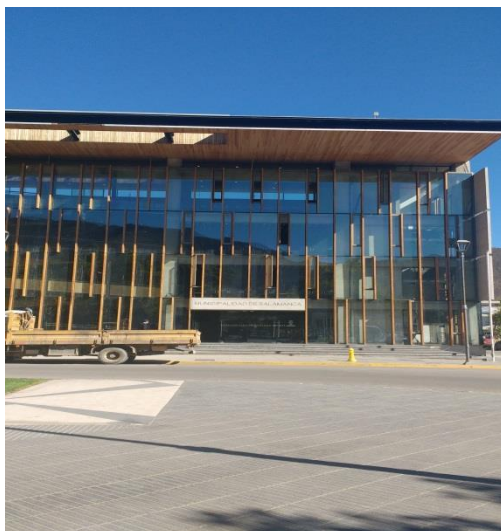
Ilustración - Fachada edificio seleccionado
