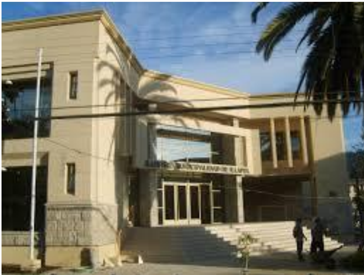
Ilustración - Fachada edificio seleccionado
