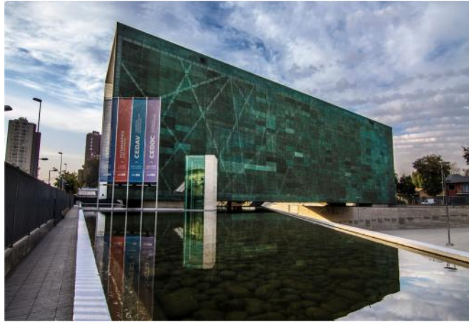
Ilustración - Fachada edificio seleccionado
