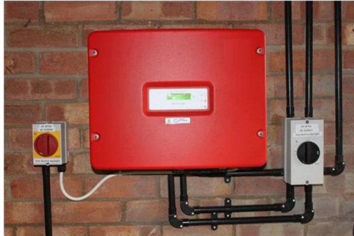
Ilustración -Típico montaje de un inversor
