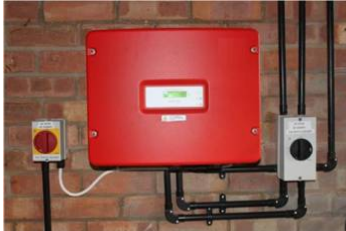
Ilustración -Típico montaje de un inversor
