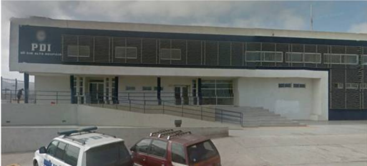
Ilustración - Fachada edificio seleccionado
