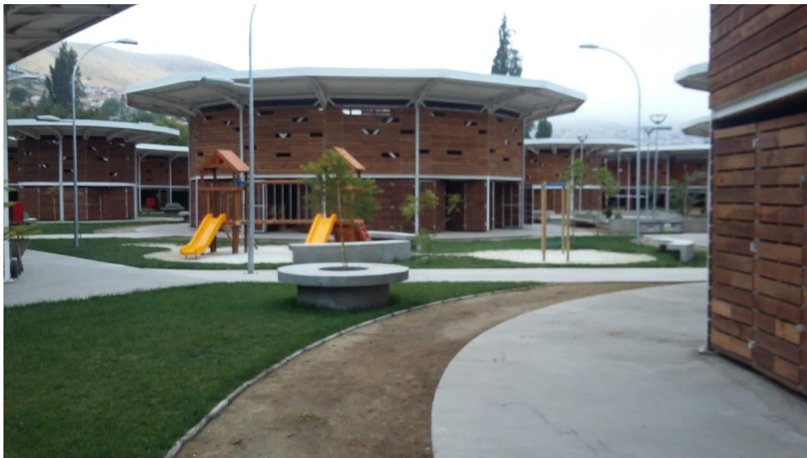
Ilustración - Fachada edificio seleccionado
