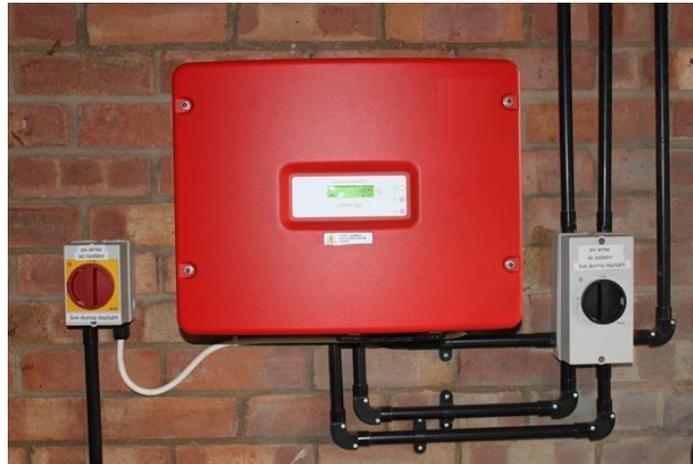
Ilustración -Típico montaje de un inversor
