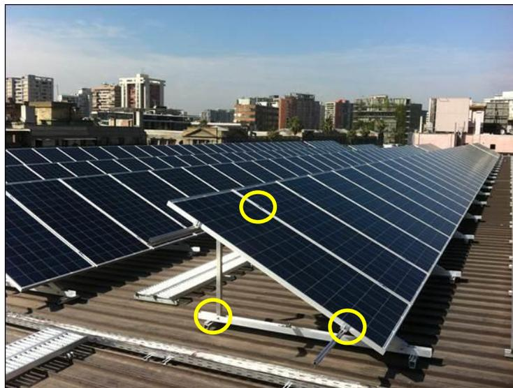
Ilustración 3. Fotografía proyecto GAM Santiago. En amarillo las grapas finales e intermedias solidarias a la estructura de soporte, la que a su vez se fija a las costaneras de la techumbre del edificio
