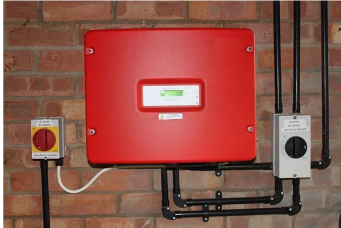
Ilustración -Típico montaje de un inversor
