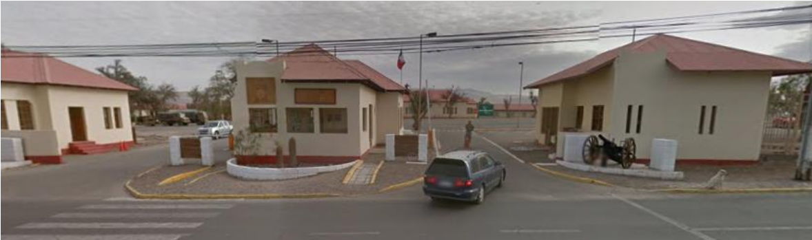
Ilustración - Fachada edificio seleccionado
