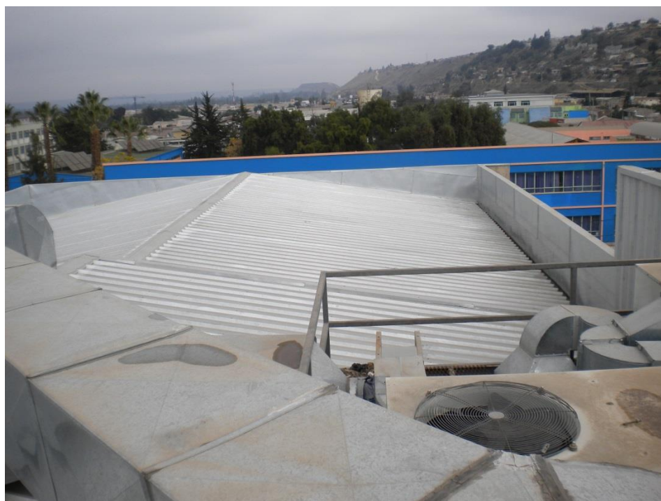
Ilustración – Techo (2) seleccionado
