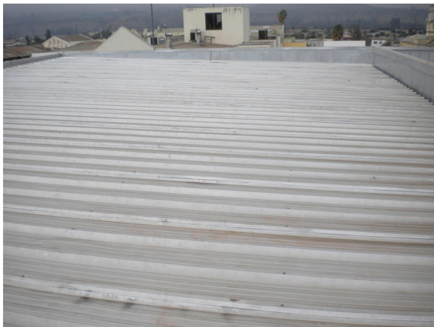
Ilustración – Techo (1) seleccionado
