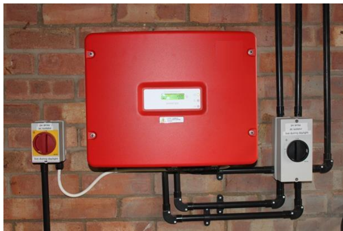
Ilustración -Típico montaje de un inversor
