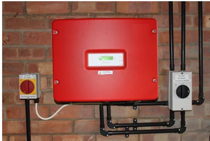
Ilustración -Típico montaje de un inversor
