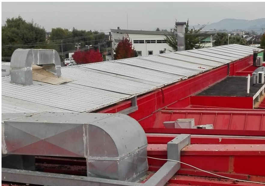
Ilustración – Techo seleccionado (1)
