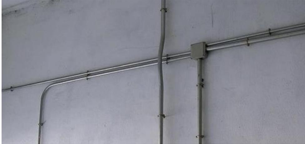
Ilustración 8: ejemplo de instalación bajo tubo.
