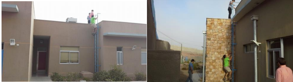
Ilustración6. Escaleras de acceso.
