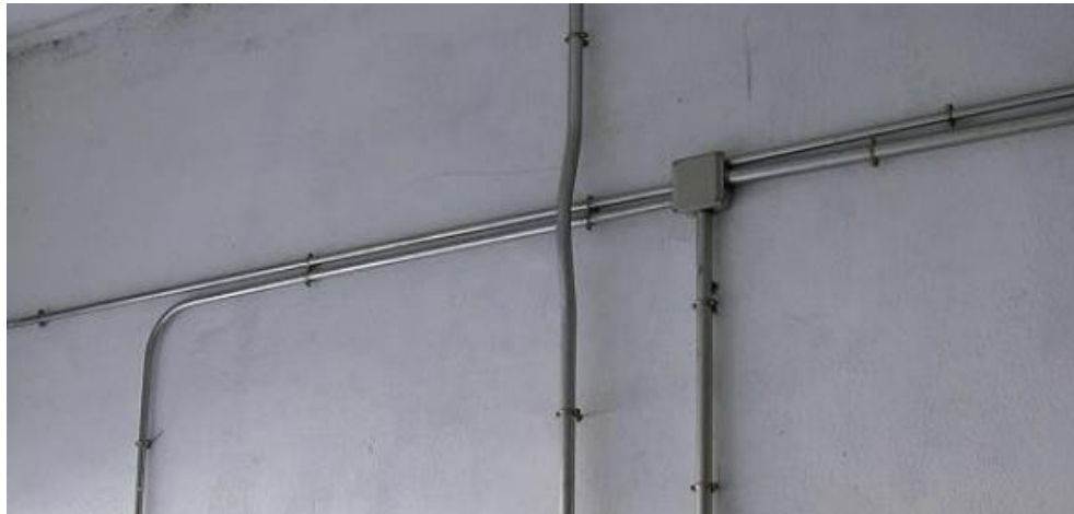
Ilustración 223 . Ejemplo de instalación bajo tubo.
