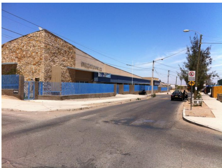
Ilustración 1. Fachada del edificio.
