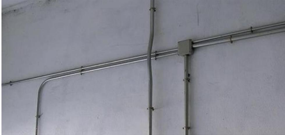
Ilustración 8: ejemplo de instalación bajo tubo.
